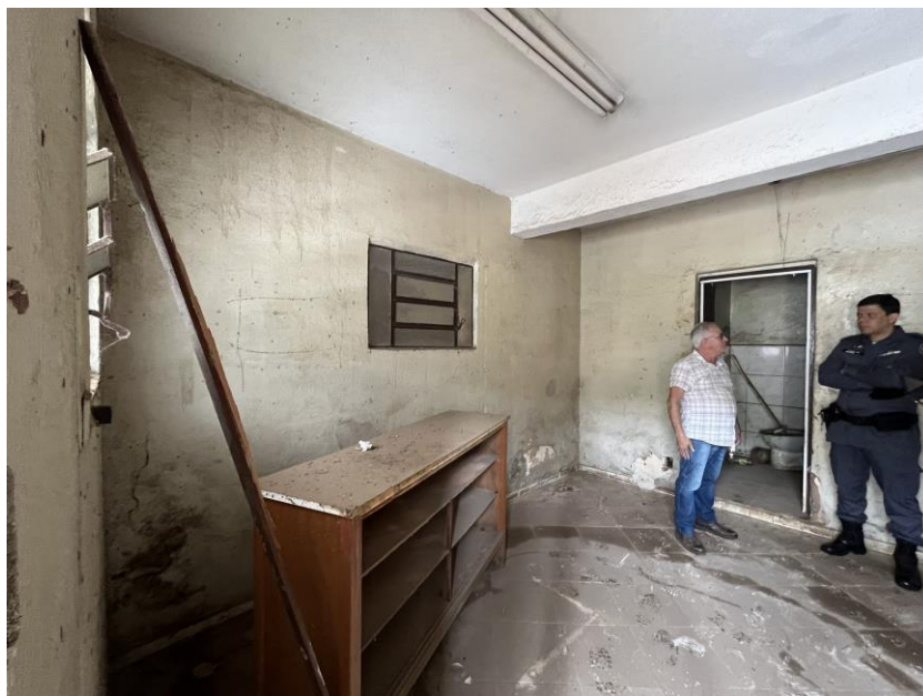
Imagem 02- Vista do pavimento térreo do imóvel.
