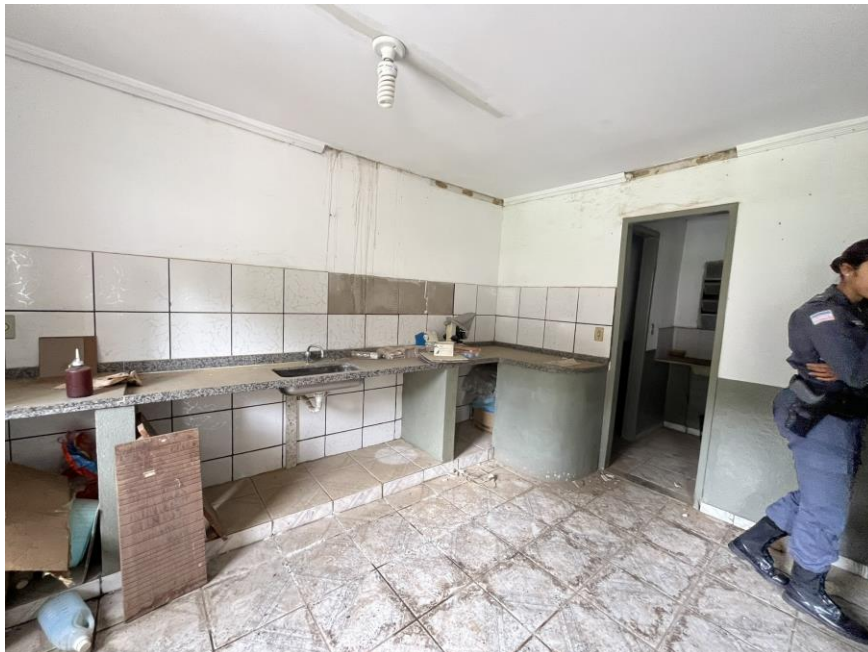
Imagem 08- Vista do 1º pavimento do imóvel.
