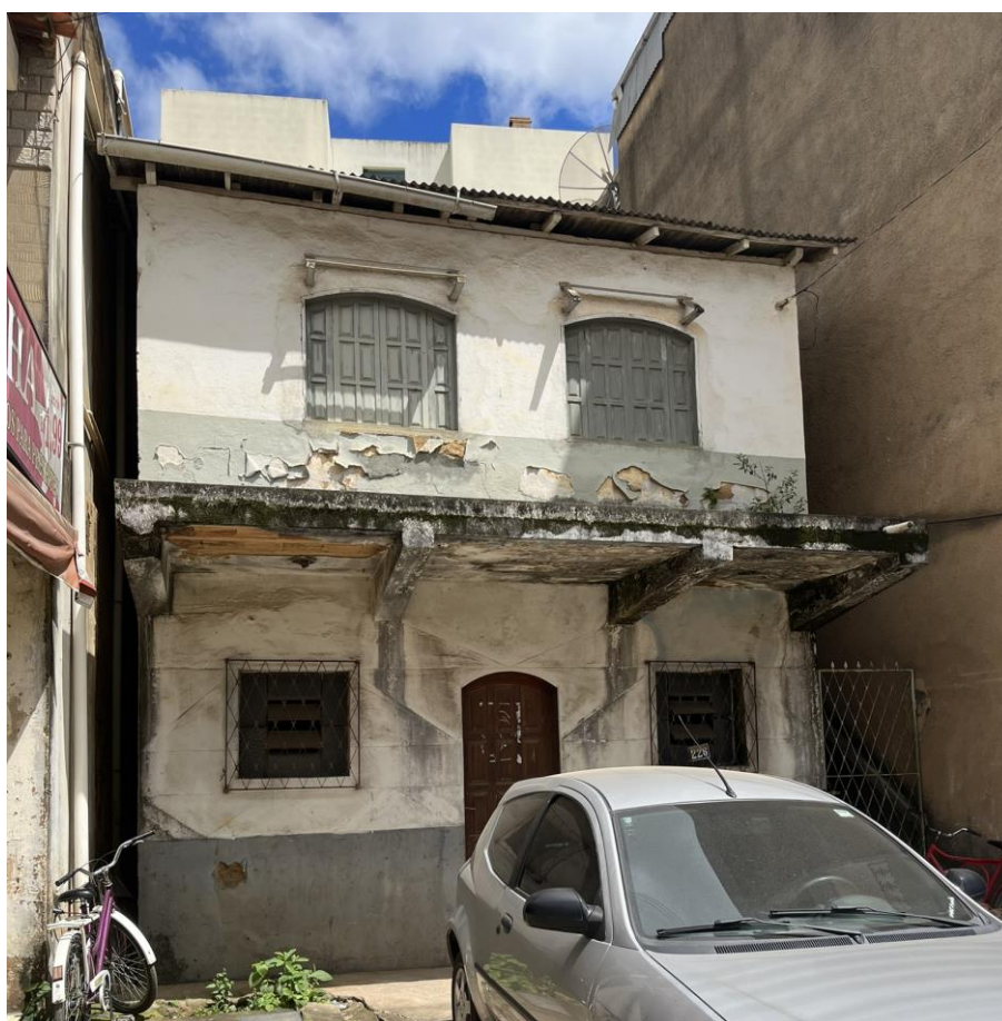
Imagem 01- Vista da fachada do imóvel.
