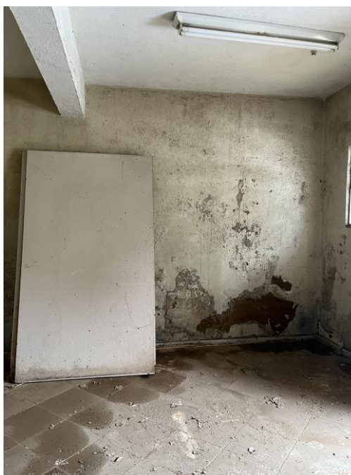
Imagem 04- Vista do pavimento térreo do imóvel.
