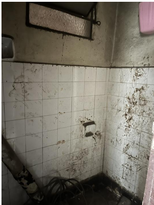
Imagem 06- Vista do pavimento térreo do imóvel.
