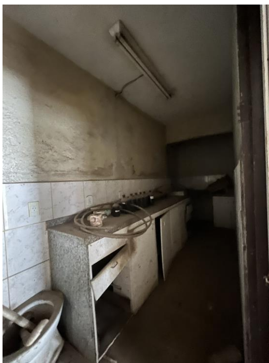
Imagem 05- Vista do pavimento térreo do imóvel.
