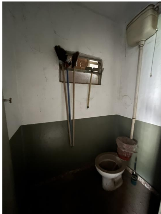
Imagem 10 - Vista do 1º pavimento do imóvel.
