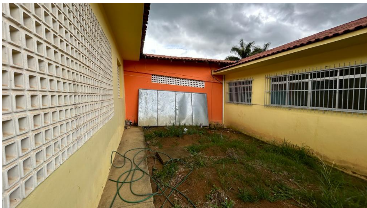
Figura 3. Área onde será construída a rampa
