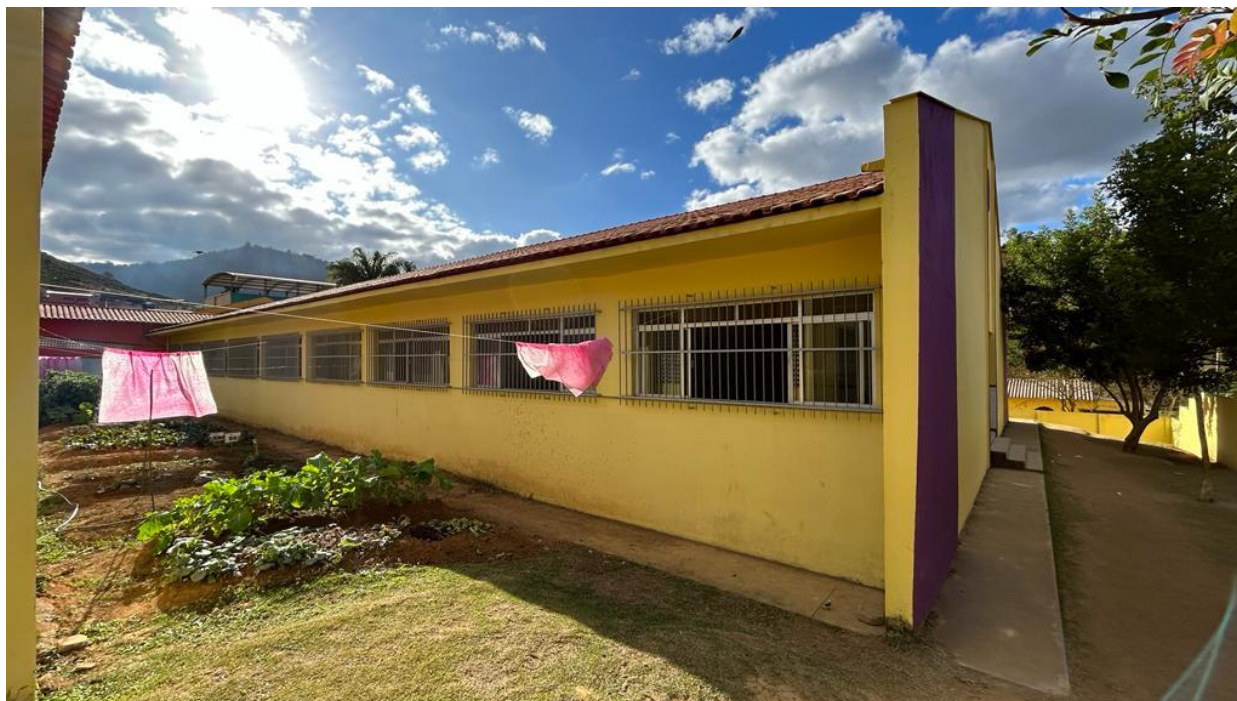
Figura 2. Fundos (bloco 02, que receberá a construção do 1º pavimento)
