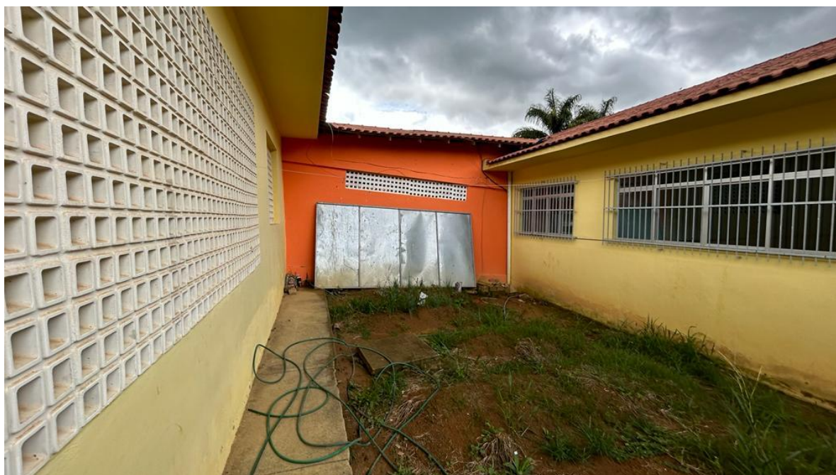
Figura 3. Área onde será construída a rampa
