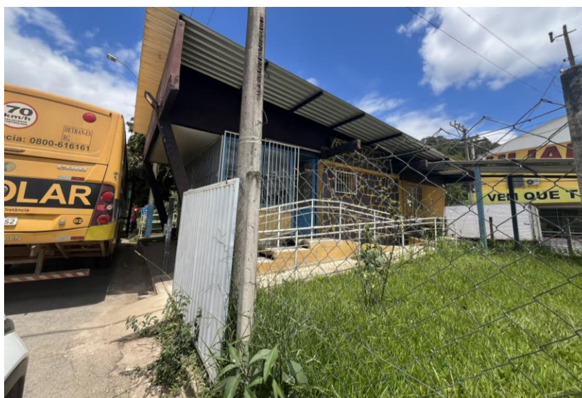
Imagem 01- Vista do imóvel a ser reformado.
