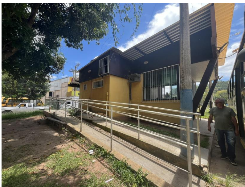
Imagem 02- Vista do imóvel a ser reformado.
