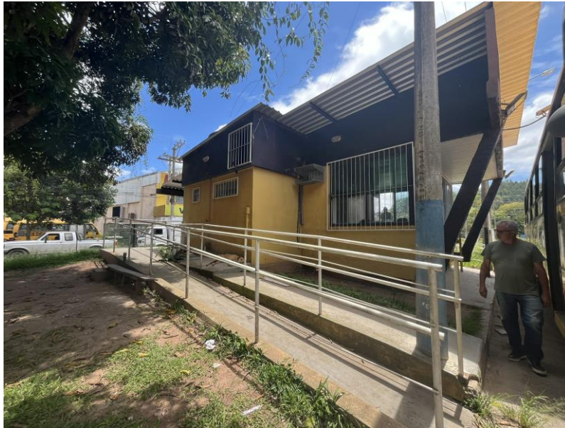
Imagem 02- Vista do imóvel a ser reformado.
