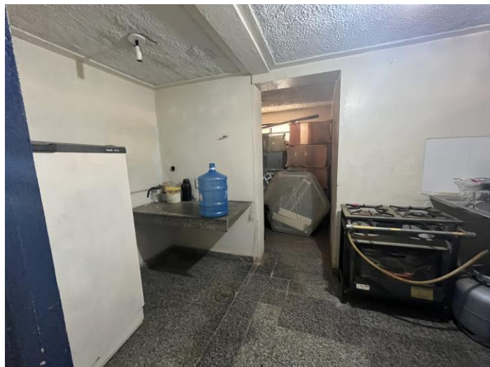
Imagem 04- Vista do interior do imóvel a ser reformado.
