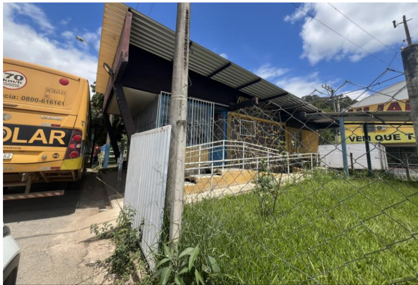
Imagem 01- Vista do imóvel a ser reformado.
