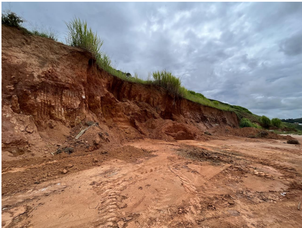
Imagem 02- Vista da área onde será construída a rodoviária.
