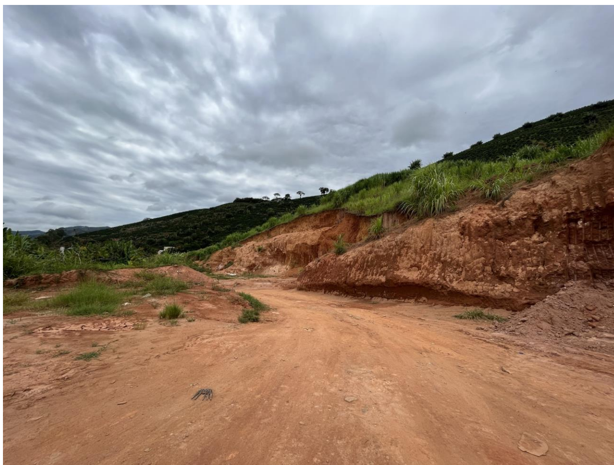
Imagem 01 - Vista da área onde será construída a rodoviária.
