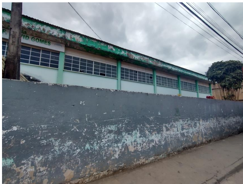
Imagem 05- Vista do muro da escola.
