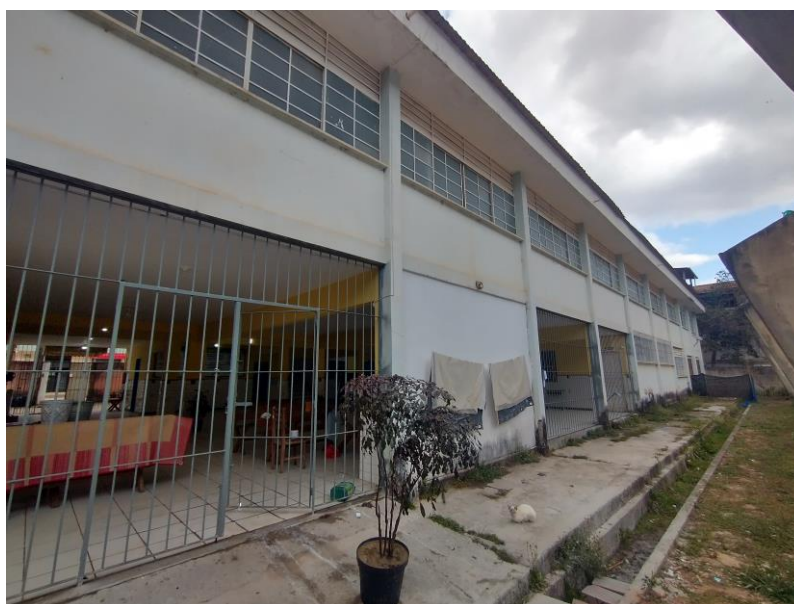
Imagem 07 - Vista dos fundos.
