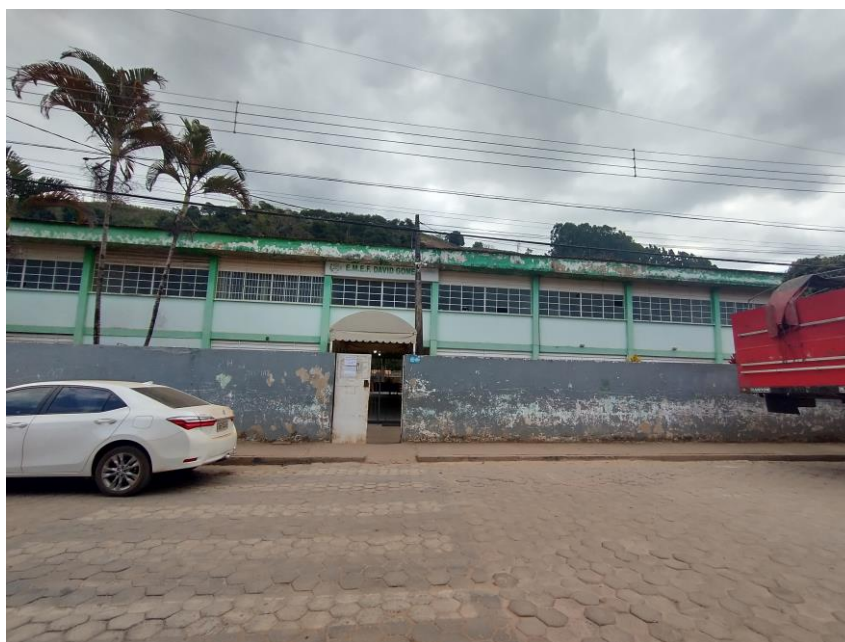
Imagem 01 - Vista da fachada do prédio.
