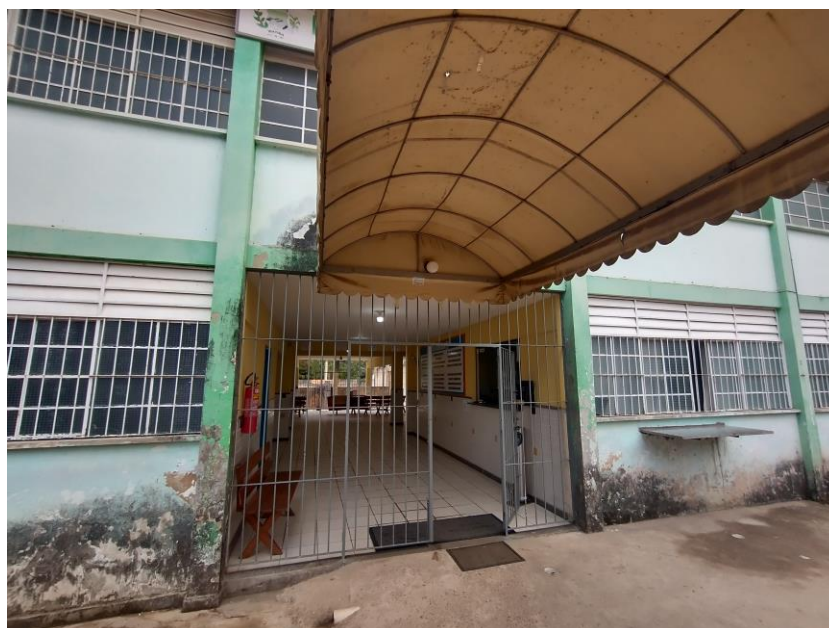
Imagem 03 - Vista da fachada do prédio.
