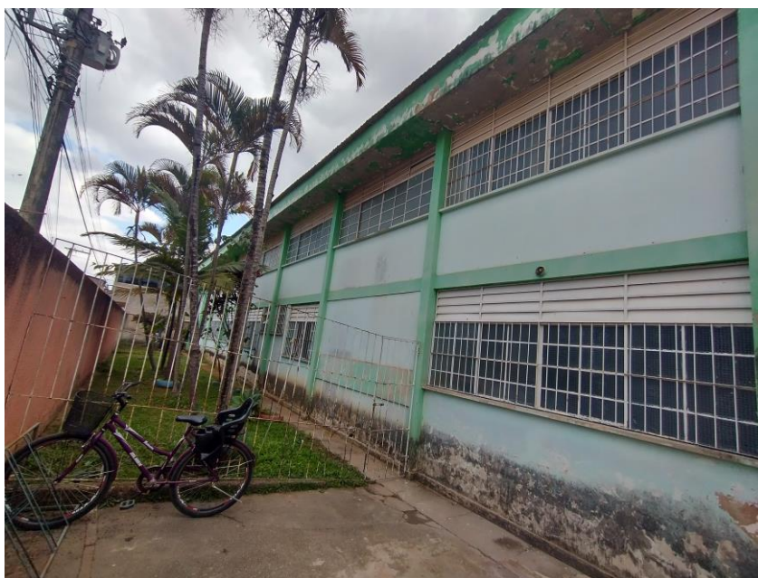
Imagem 02- Vista da fachada do prédio.
