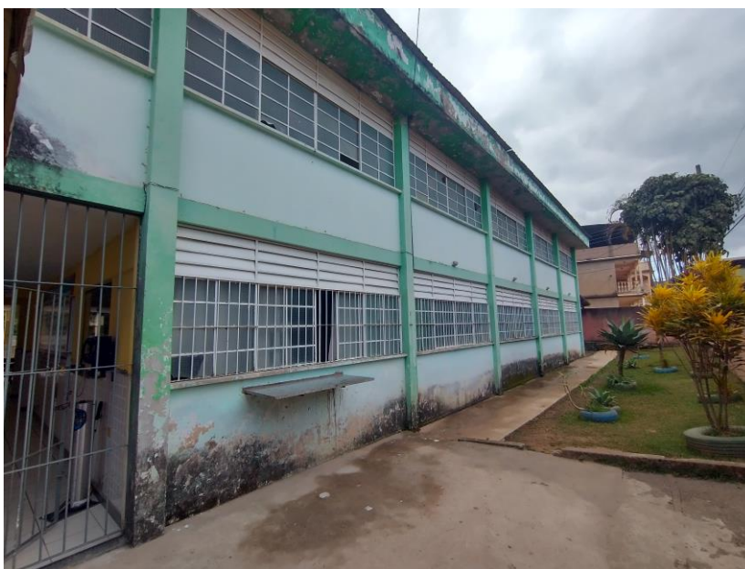
Imagem 04 - Vista da fachada do prédio.
