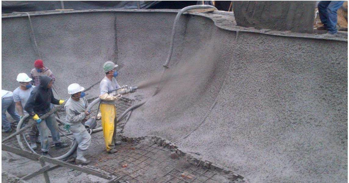
Figura 8 - Foto ilustrativa da projeção de concreto magro
