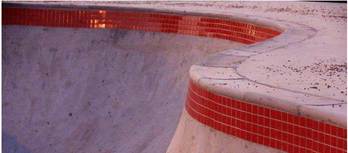
Figura 212 - Revestimento de pastilhas
