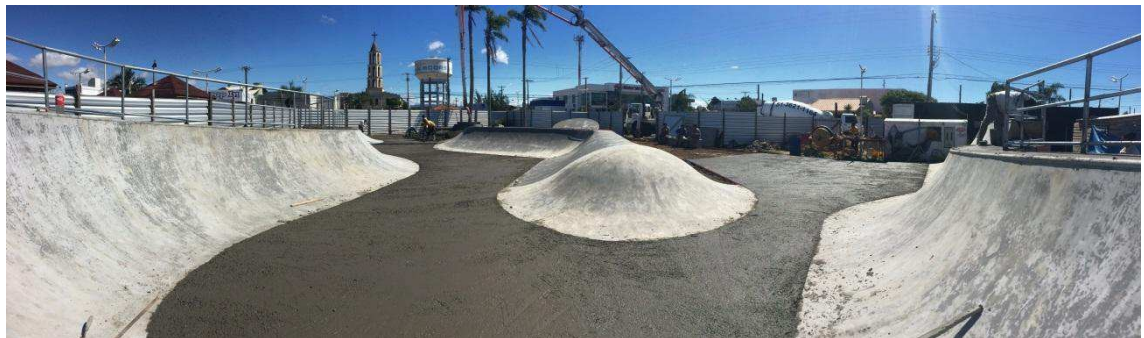
Figura 14 - Foto ilustrativa da concretagem de pisos planos
