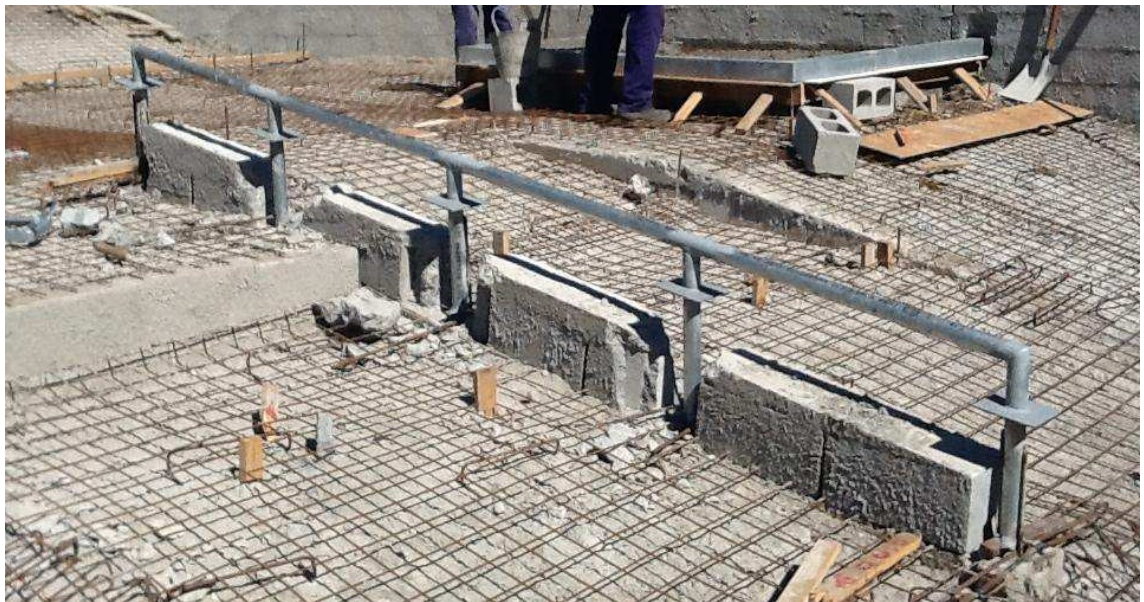
Figura 6 - Foto ilustrativa do corrimão sendo chumbado
