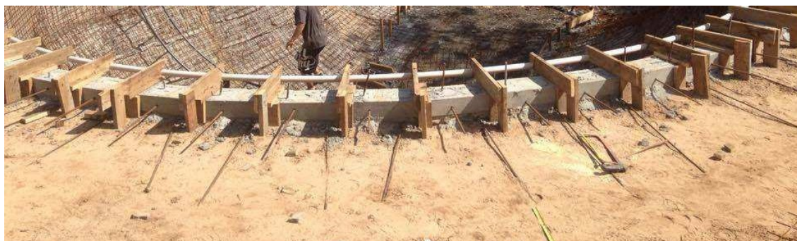
Figura 13 - Foto ilustrativa das barras de transferência
