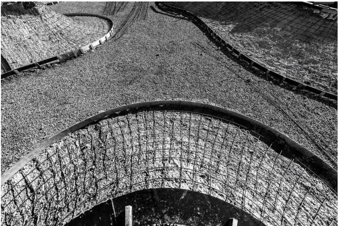
Figura 12 - Foto ilustrativa das armaduras da laje de piso
