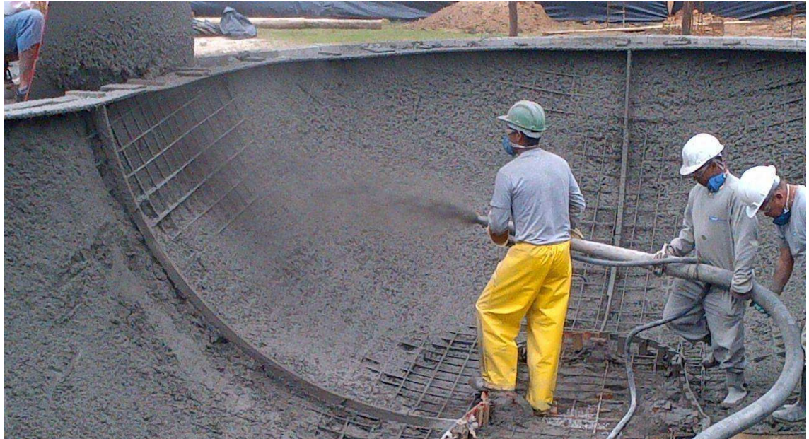
Figura 17 - Foto ilustrativa da projeção de concreto
