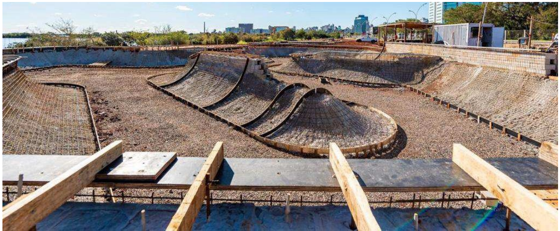
Figura 10 - Foto ilustrativa das formas de madeira
