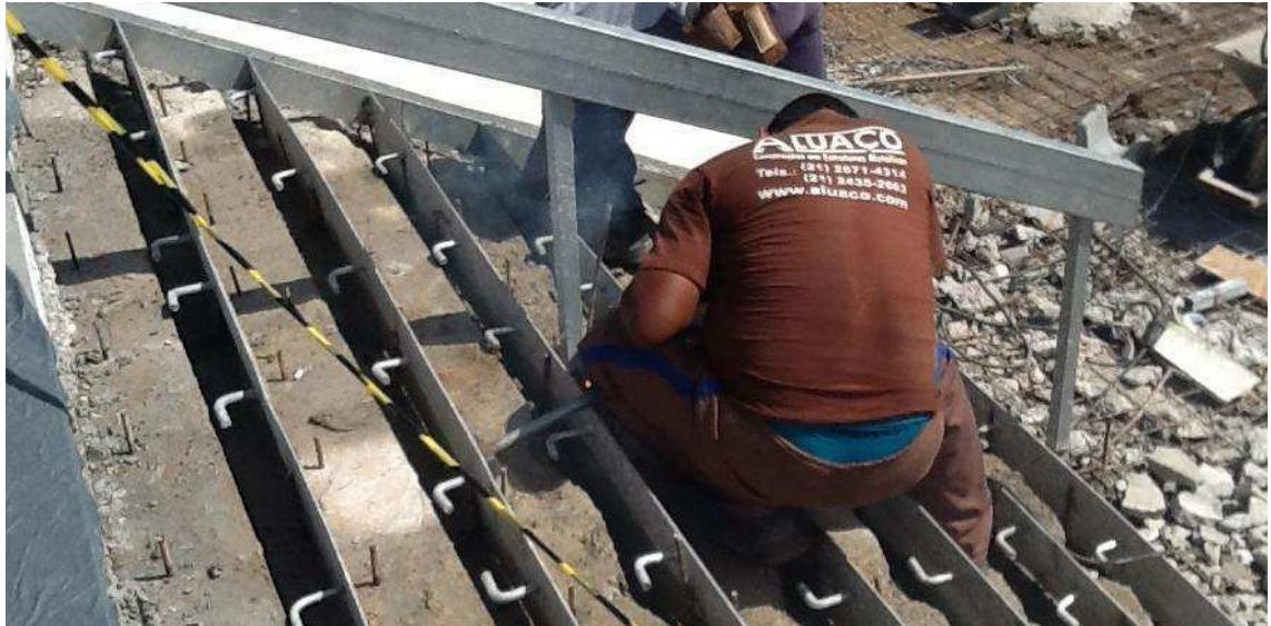
Figura 7 - Foto ilustrativa do corrimão sendo chumbado
