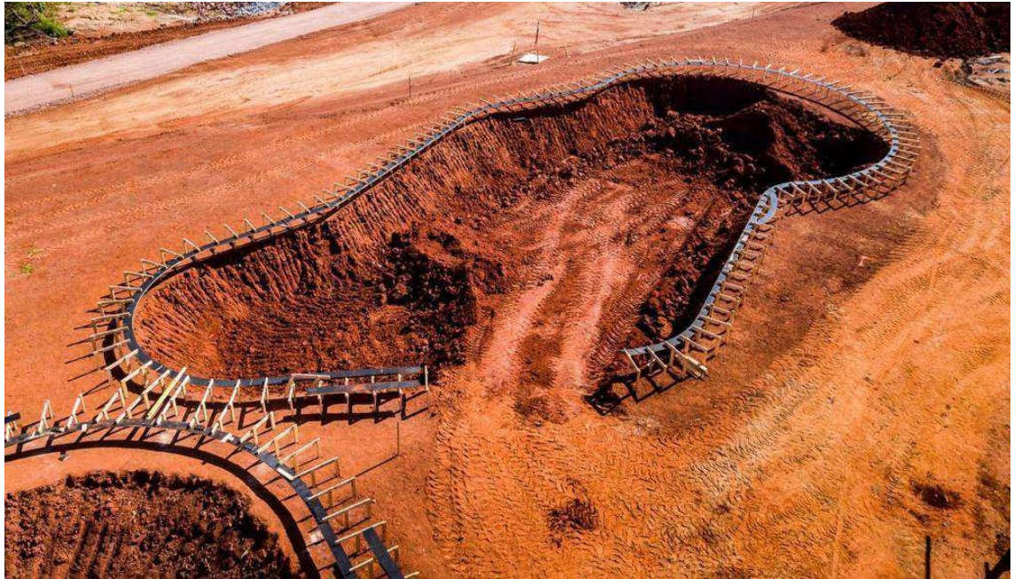
Figura 1- Foto ilustrativas da escavação
