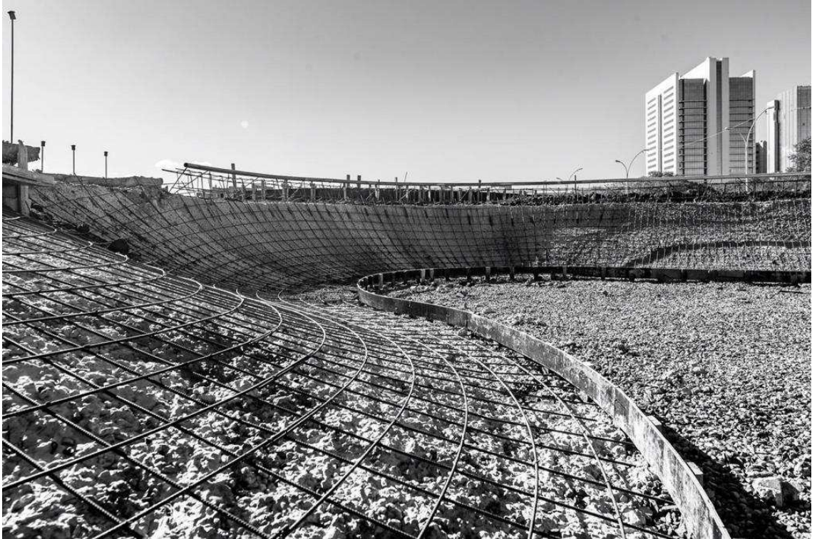
Figura 11 - Foto ilustrativa das armaduras da laje de piso
