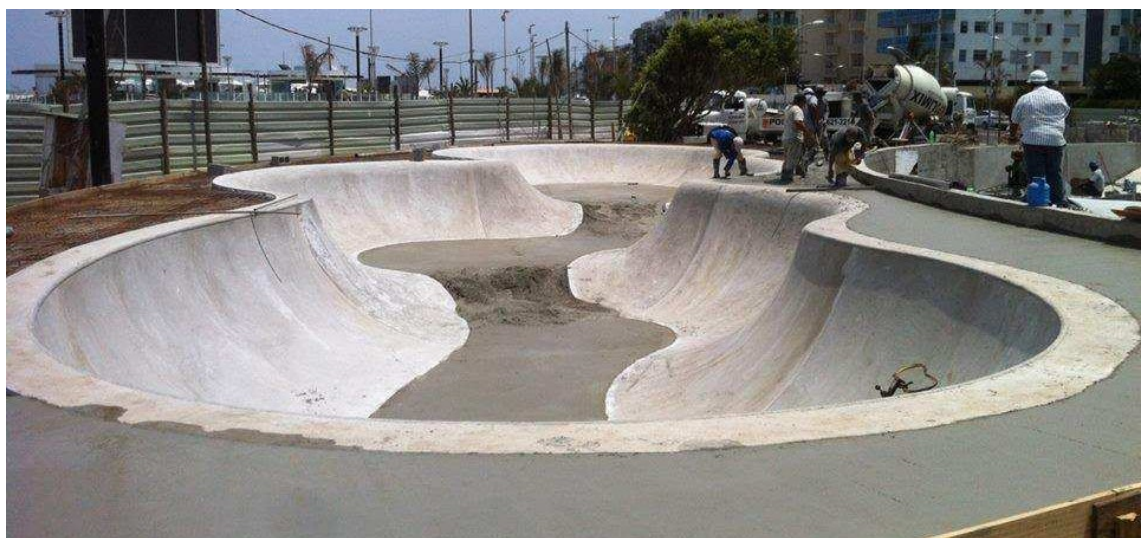
Figura 15 - Foto ilustrativa da concretagem de pisos planos
