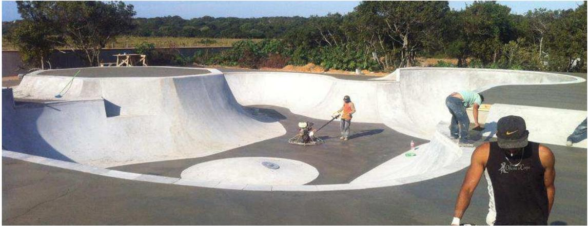
*Figura 16 - Foto ilustrativa da concretagem de pisos planos*
