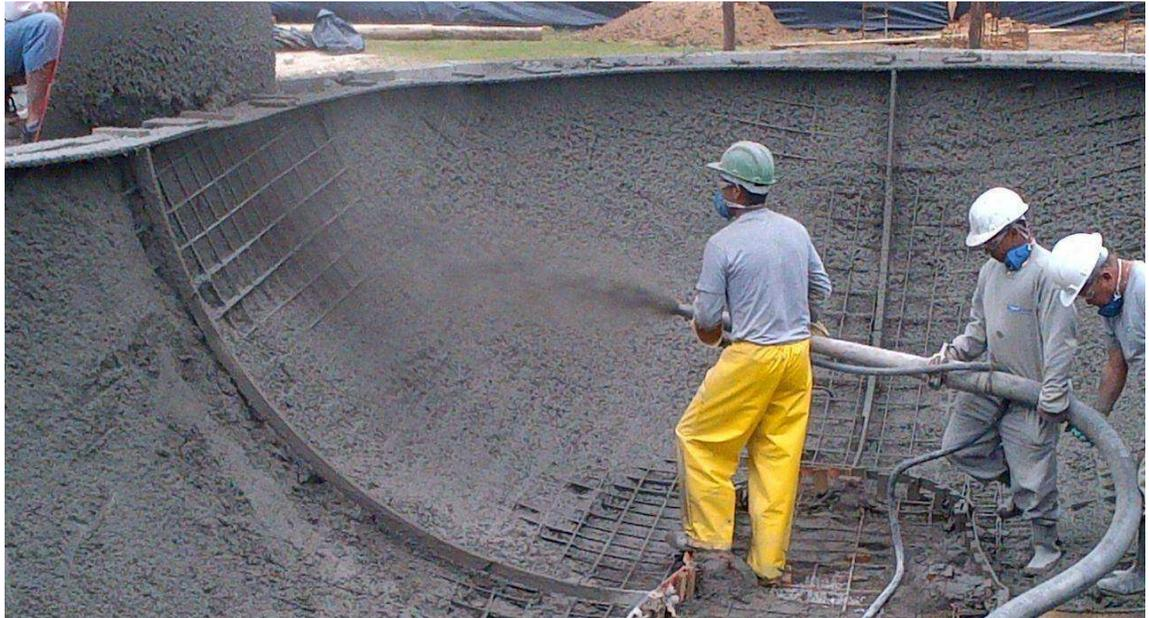
Figura 17 - Foto ilustrativa da projeção de concreto
