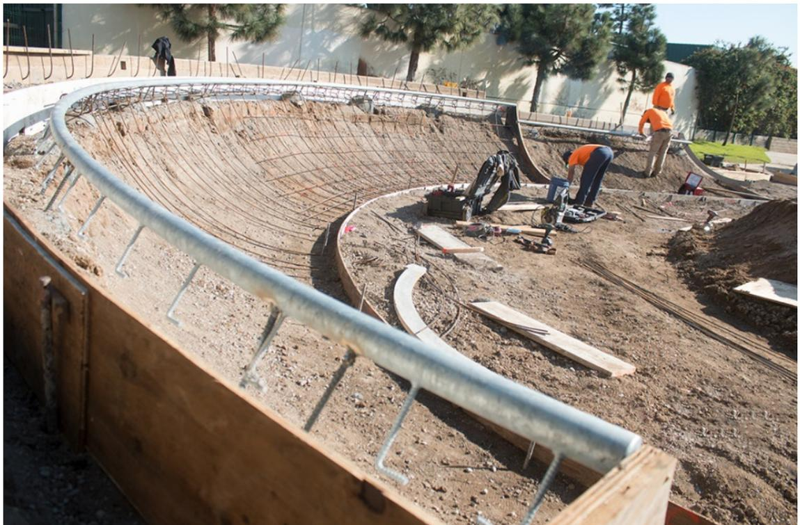
Figura 5 - Foto ilustrativa do coping metálico
