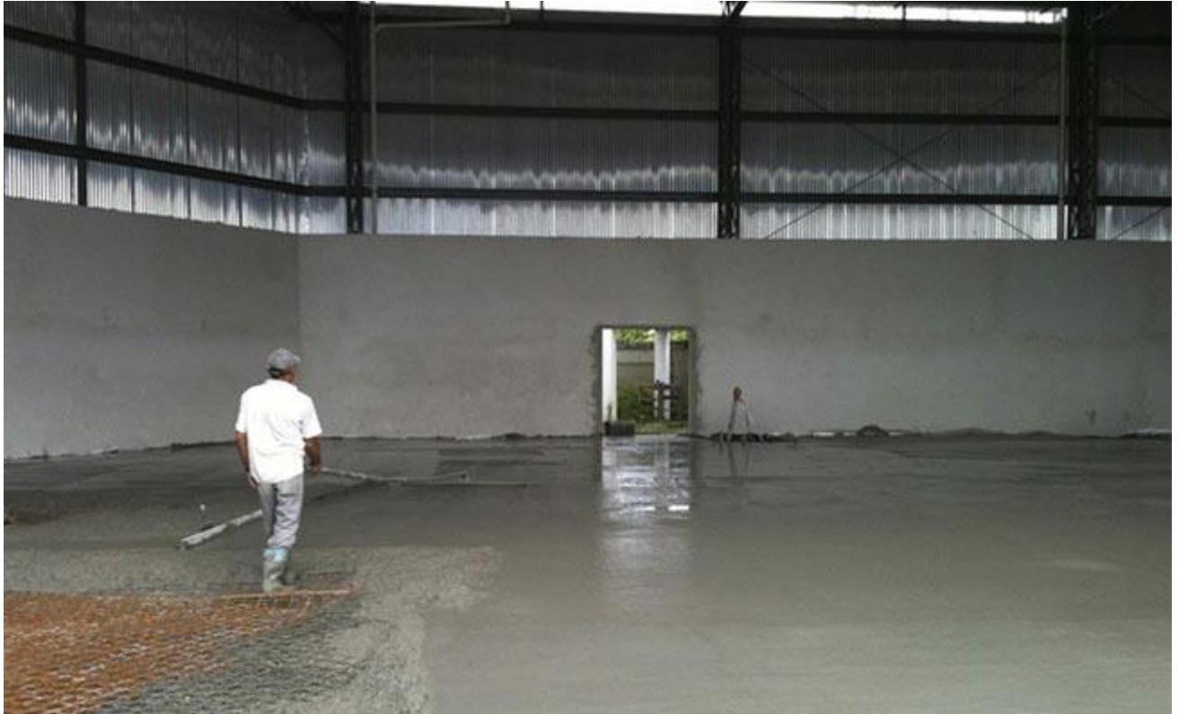
IMAGEM 04: REGULARIZAÇÃO DA SUPERFÍCIE
