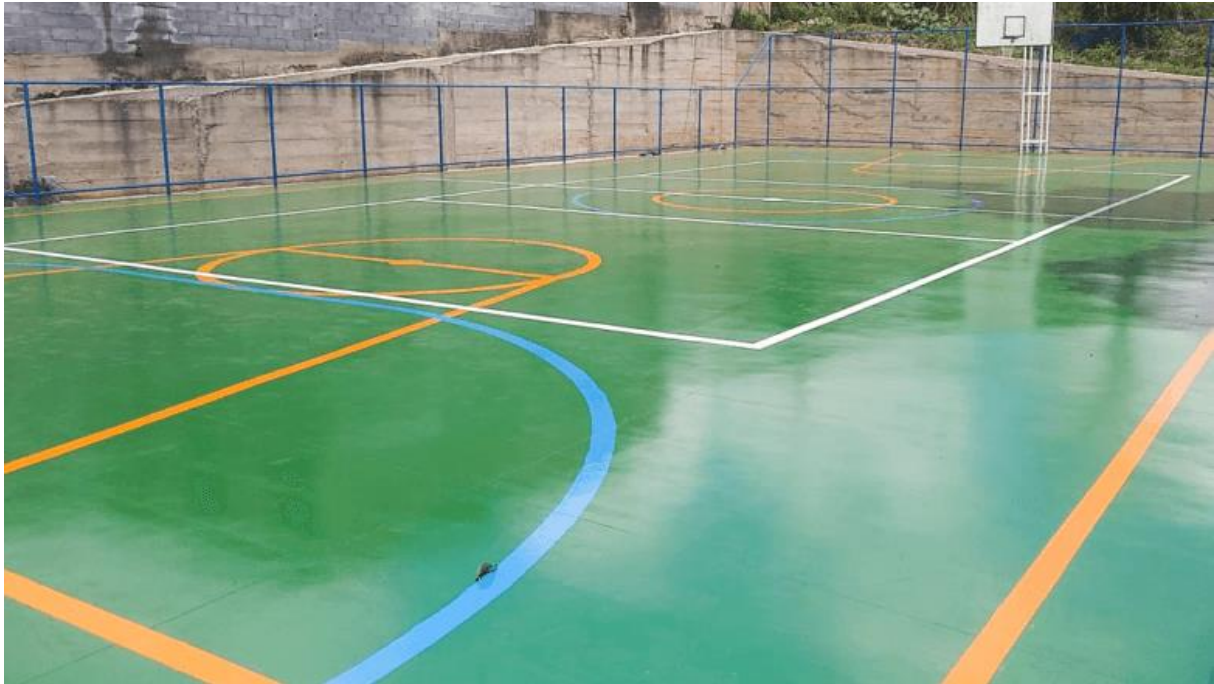
IMAGEM 07: EXEMPLO DE PINTURA E DEMARCAÇÃO COM TINTA EPÓXI
