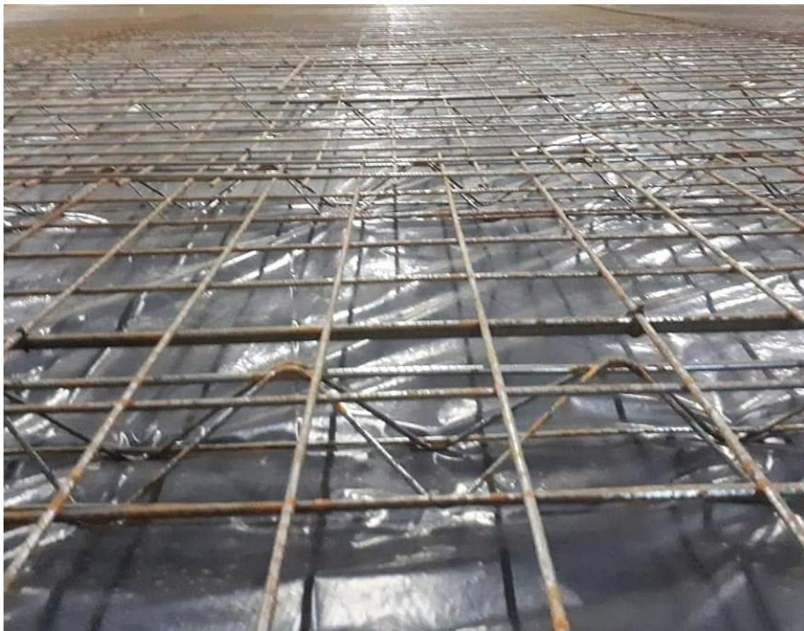
IMAGEM 02: COLOCAÇÃO DE MALHA SOBRE ISOLAMENTO COM FILME PLÁSTICO
