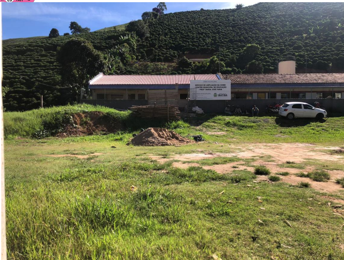
FOTO 03: ÁREA DESTINADA A CONSTRUÇÃO DA PRAÇA.
