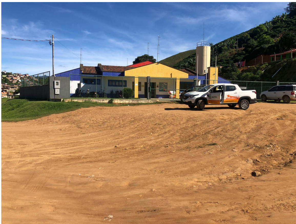
FOTO 02: ÁREA DESTINADA A CONSTRUÇÃO DA PRAÇA.
