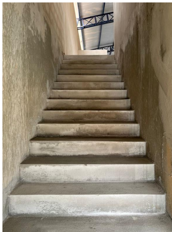
FOTO 2: ESCADA DE ACESSO AO PAVIMENTO SUPERIOR
