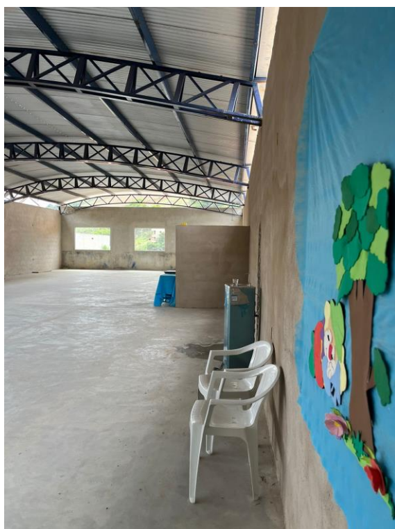
FOTO 3: VISTA PARA A FRENTE DA EDIFICAÇÃO – PAVIMENTO SUPERIOR
