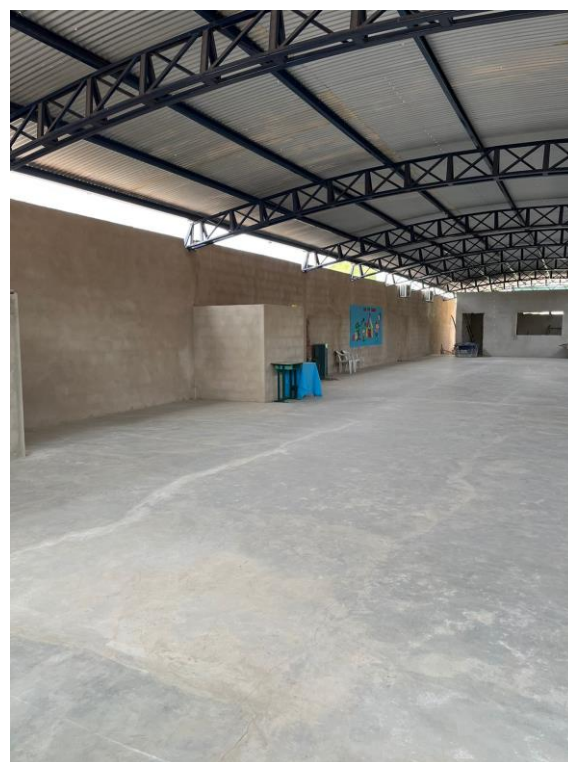
FOTO 4: VISTA PARA OS FUNDOS DA EDIFICAÇÃO – PAVIMENTO SUPERIOR
