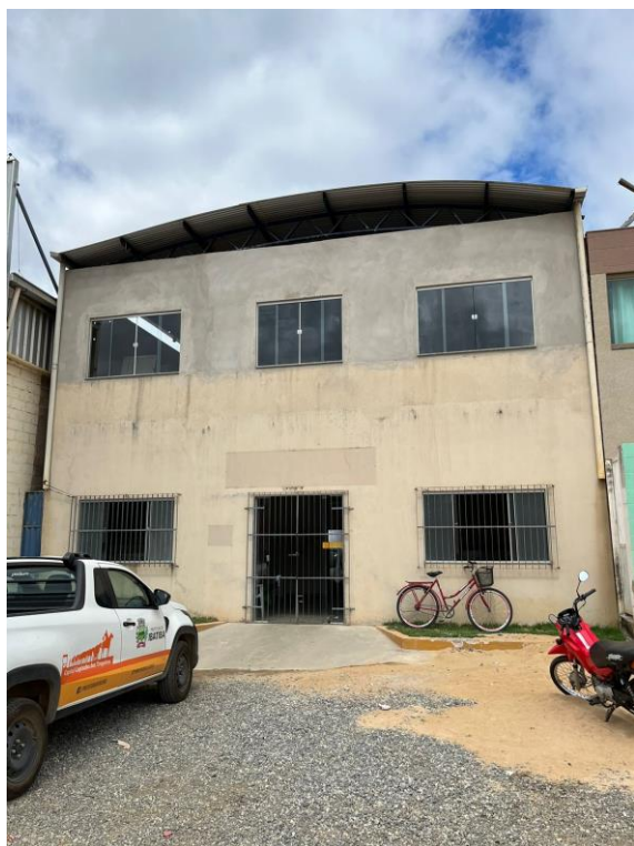
FOTO 1: FACHADA DA EDIFICAÇÃO
