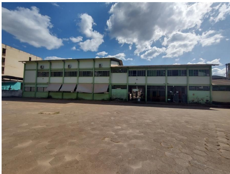
Imagem 02 – Vista dos fundos do prédio da Escola Eunice Pereira Silveira.
