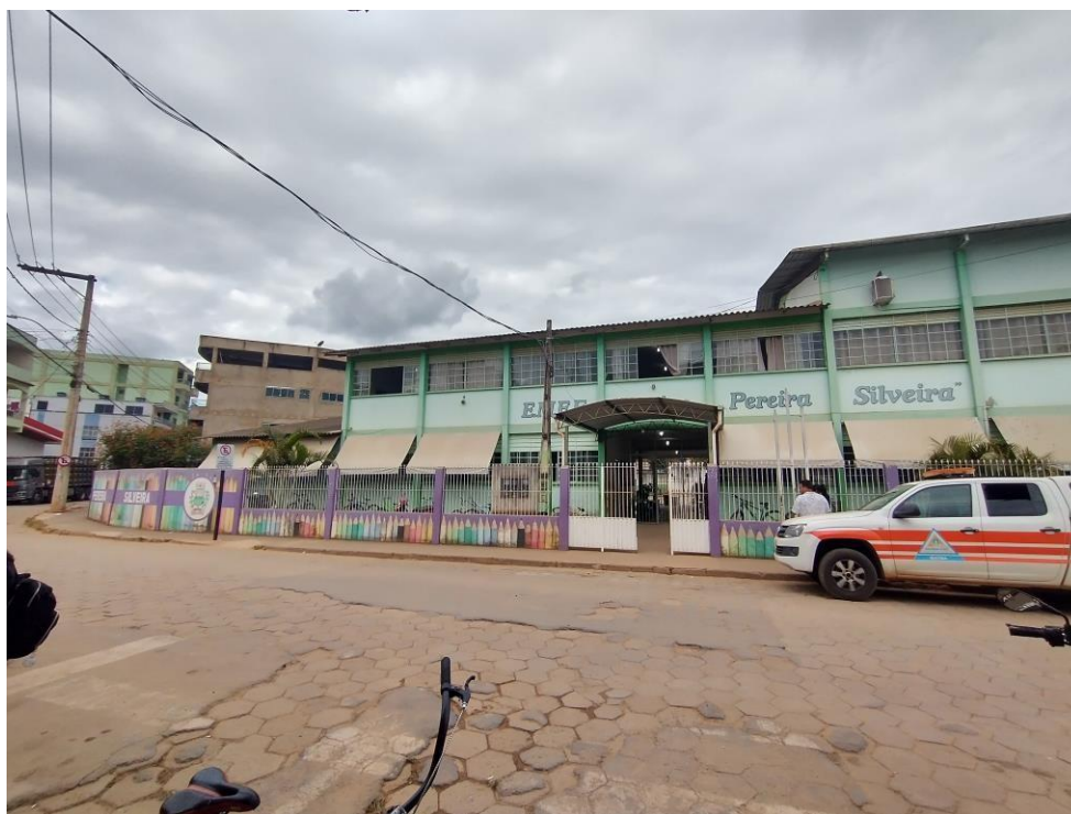
Imagem 01- Vista da fachada do prédio da Escola Eunice Pereira Silveira.
