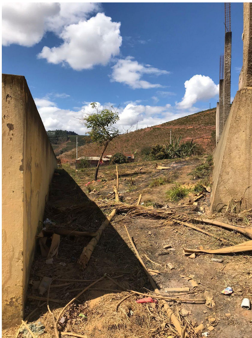
FOTO: ÁREA DE CONSTRUÇÃO DO MURO
