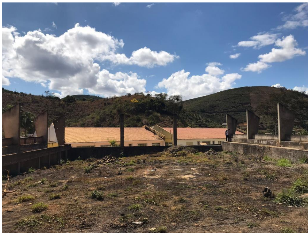
FOTO: VISTA ÁREA DA QUADRA
