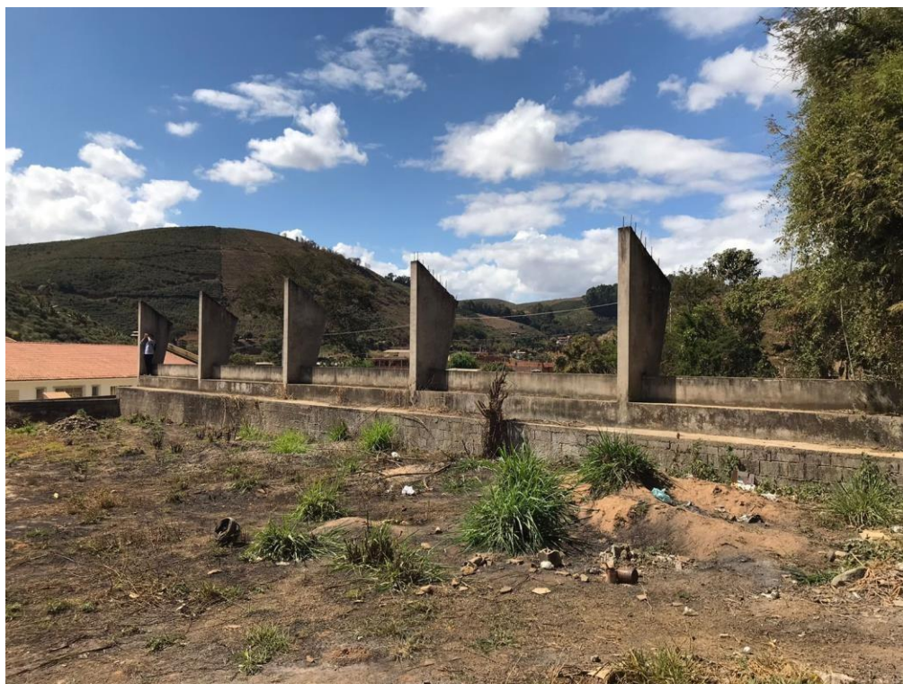
FOTO: ARQUIBANCADA FACHADA 01
