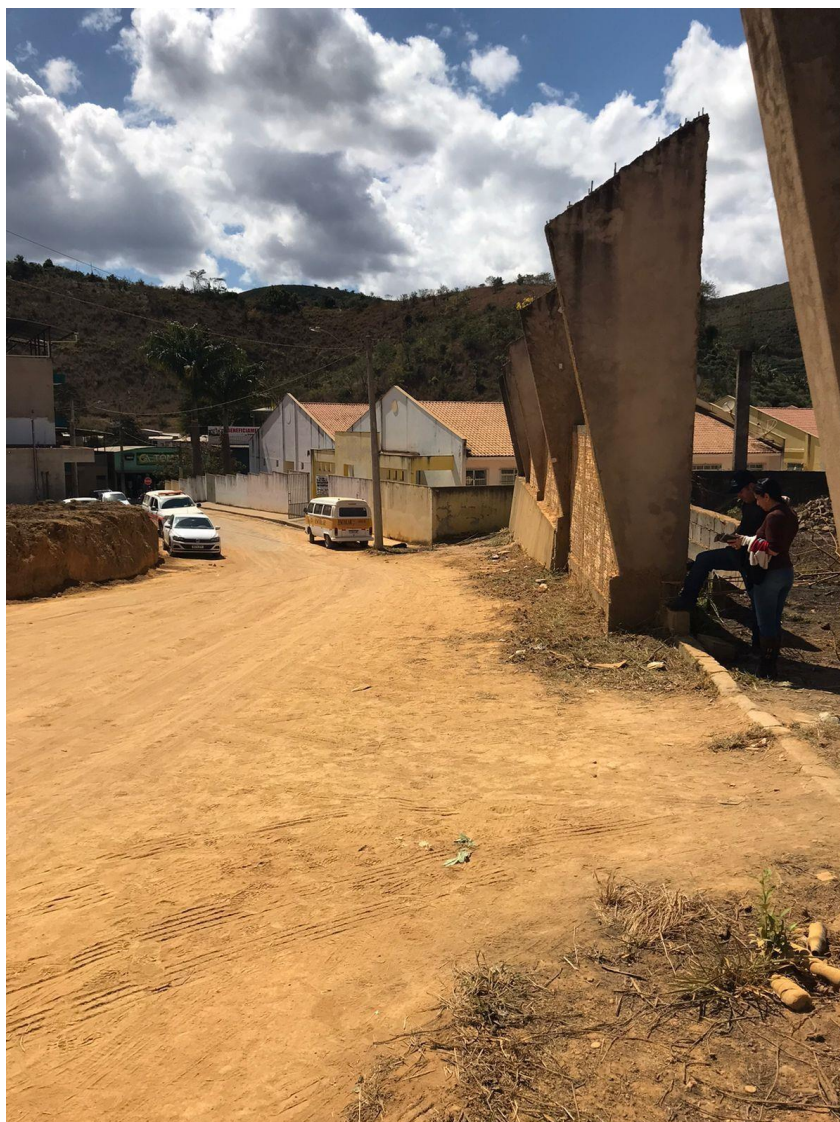
FOTO: RUA PARA ACESSO À QUADRA
