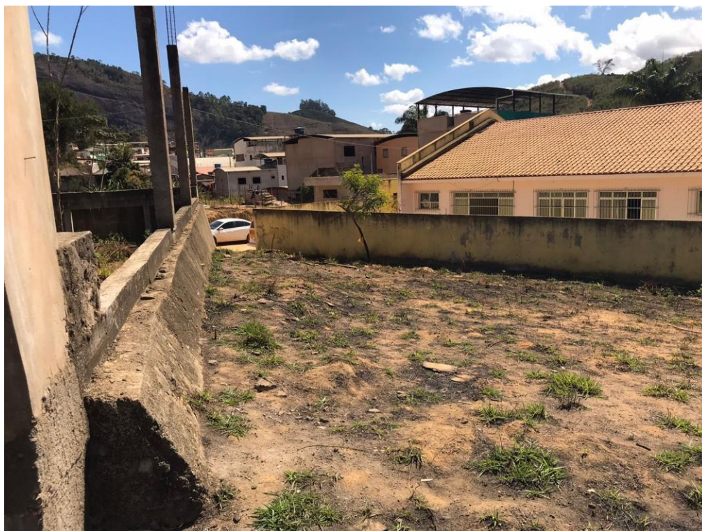
FOTO: ÁREA DE CONSTRUÇÃO DA RAMPA
