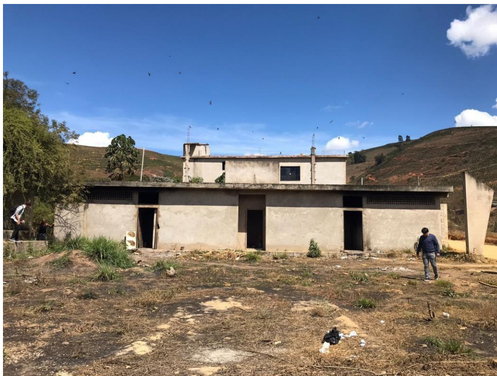
FOTO: VISTA FRONTAL VESTIÁRIOS
