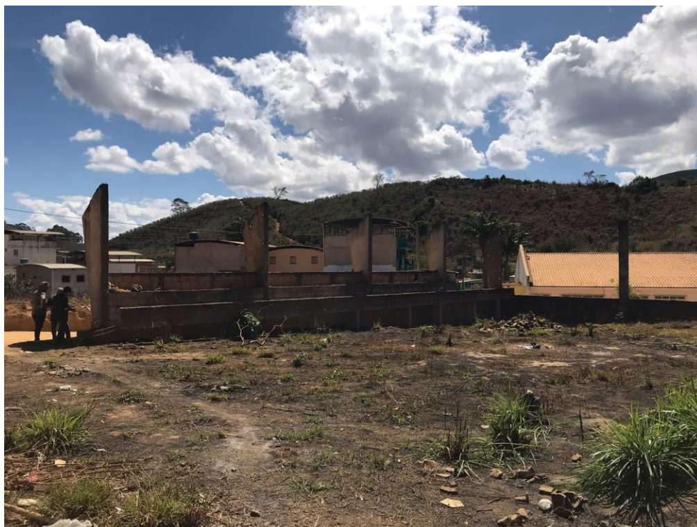
FOTO: ARQUIBANCADA FACHADA 02
