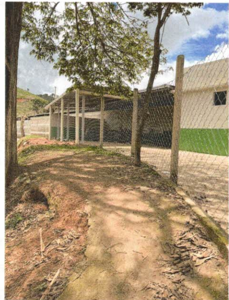
FOTO 5: Execução de alambrado
