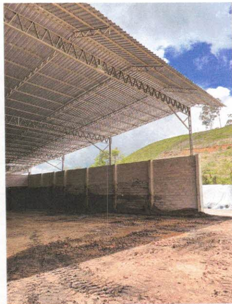
FOTO 2: Execução de cobertura metálica
