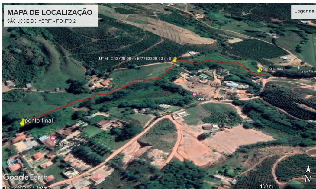
Figura 7 Limpeza no Córrego São José de Meriti ponto 2
