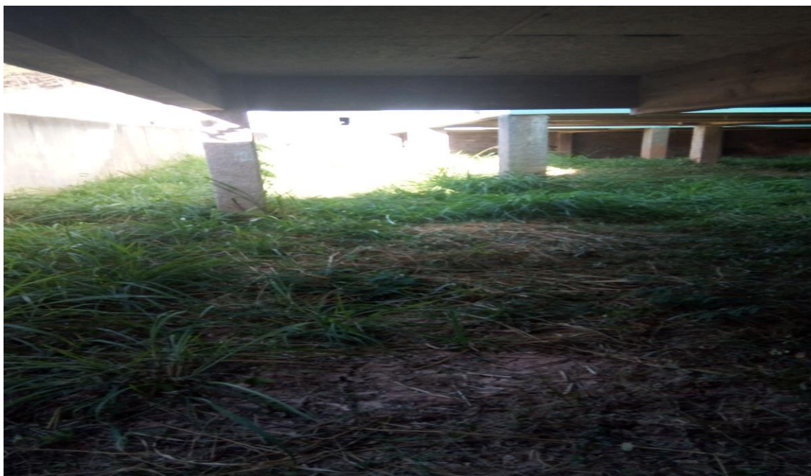
Figura 20. Capina, roçada e limpeza do terreno da edificação.
