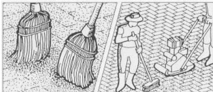
A areia é posta sobre os blocos de concreto numa fina camada (insuficiente para cobri-los totalmente) e espalhada com uma vassoura até preencher completamente as juntas. A varrição pode ser alternada (desde que se disponha do pessoal suficiente) com a compactação final.
