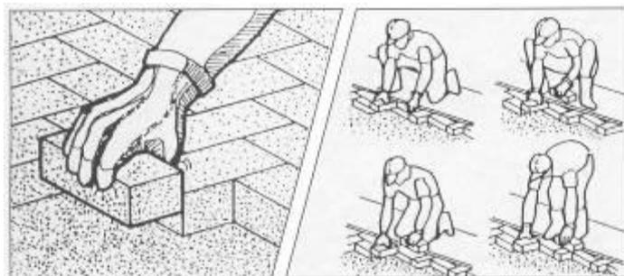
Como os blocos são colocados, principalmente, a mão, o colocador deverá usar, ao máximo, luvas de proteção. O seu trabalho, no nível do chão, é cansativo. Para evitar fadiga terá que mudar frequentemente de posição.
