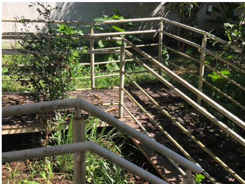
Foto – 08: Detalhe da rampa metálica externa.
