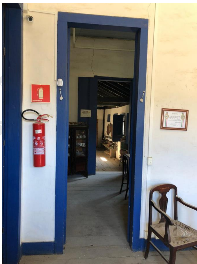
Foto – 05: Paredes internas.
