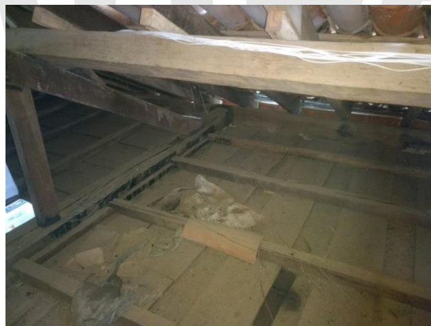
Fotos 15 e 16 - Madeiramento danificado do telhado. (Acervo próprio).
