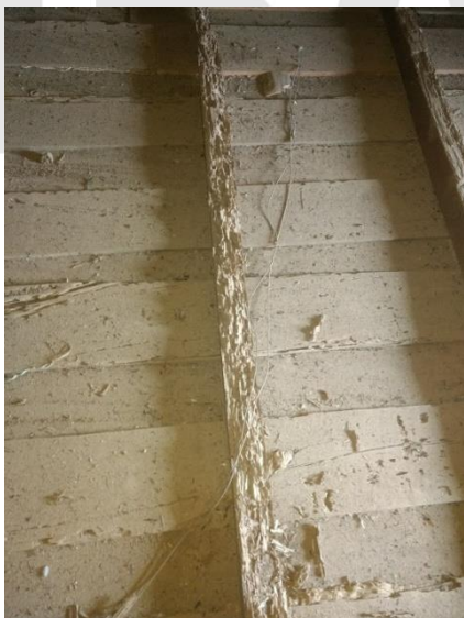
Fotos 15 e 16 - Madeiramento danificado do telhado. (Acervo próprio).
