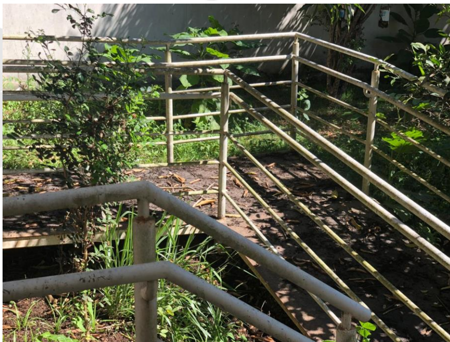
Foto 06 – DETALHA DA MPA METALICA. (Acervo próprio).
