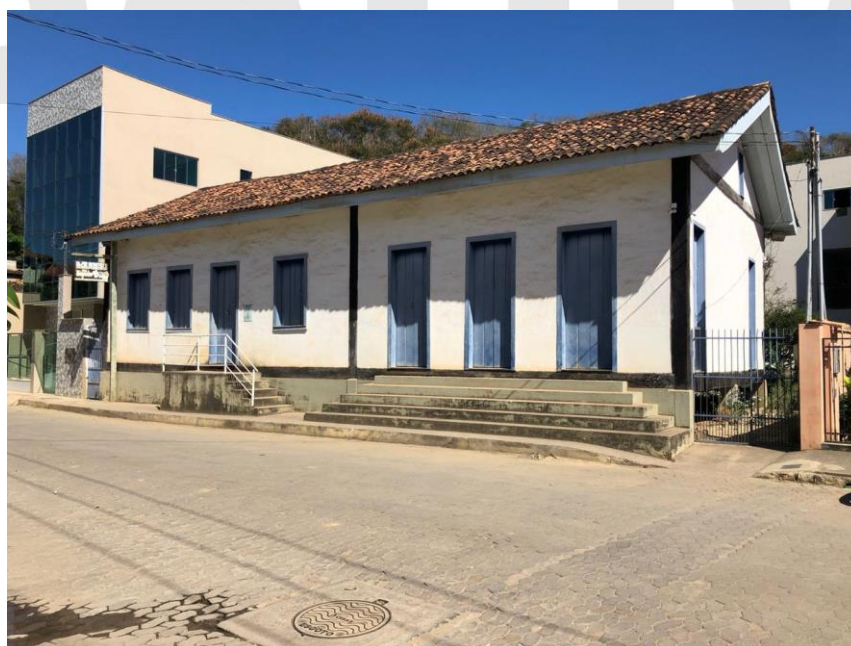
Foto – 04: Fachada frontal.
