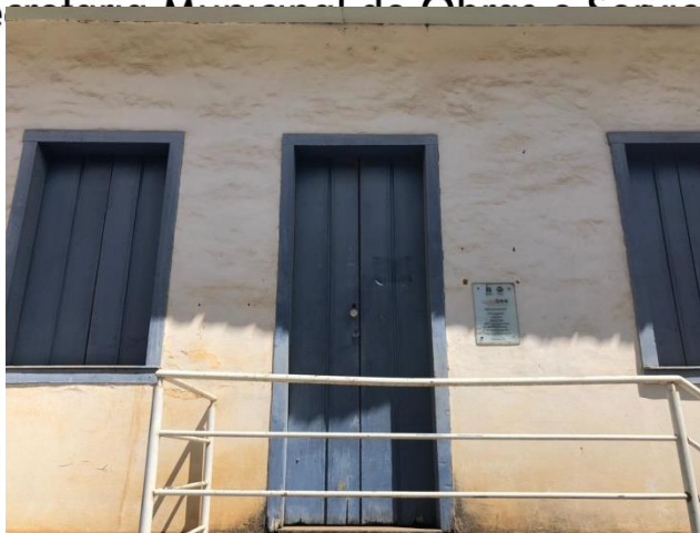
Foto12 - Esquadrias do museu. (Acervo próprio).
