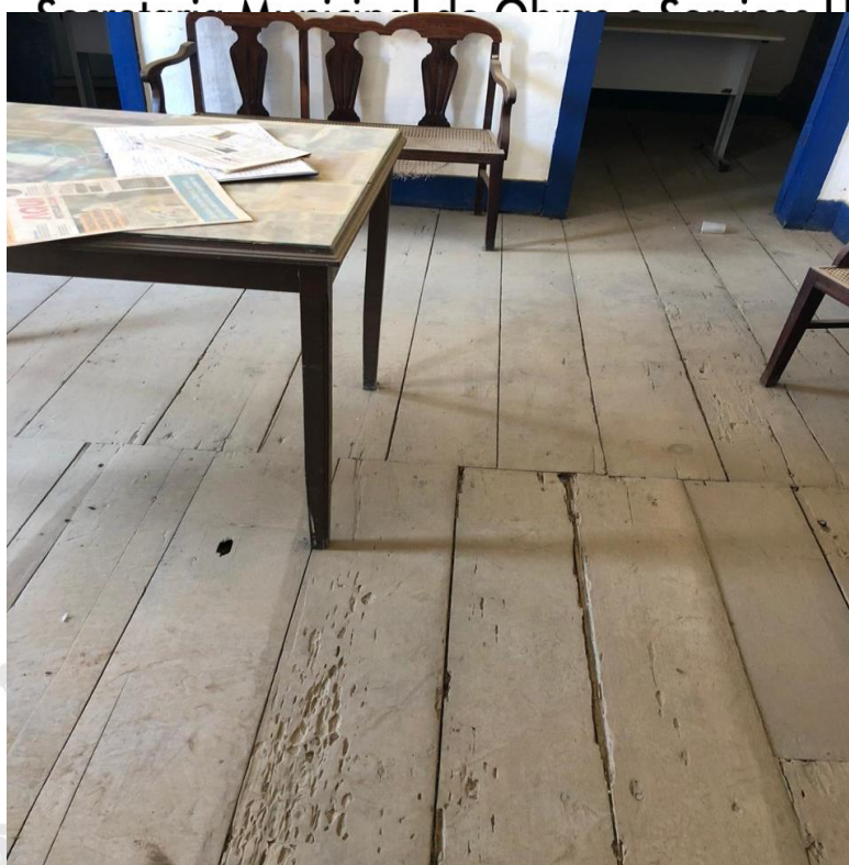
Foto11 – Assoalho com sinais de desgaste e deterioração. (Acervo próprio).
