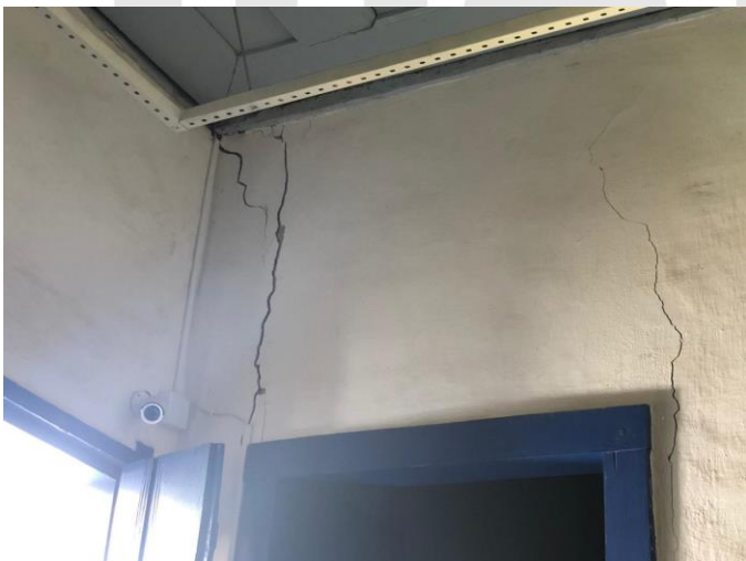
Fotos 07 e 08 – Rachaduras na alvenaria do museu. (Acervo próprio).
