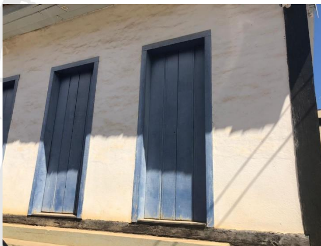
Foto13 - Esquadrias do museu. (Acervo próprio).
