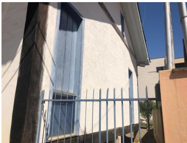
Foto14 - Esquadrias que receberão fechamento com vidro aramado. (Acervo próprio).
