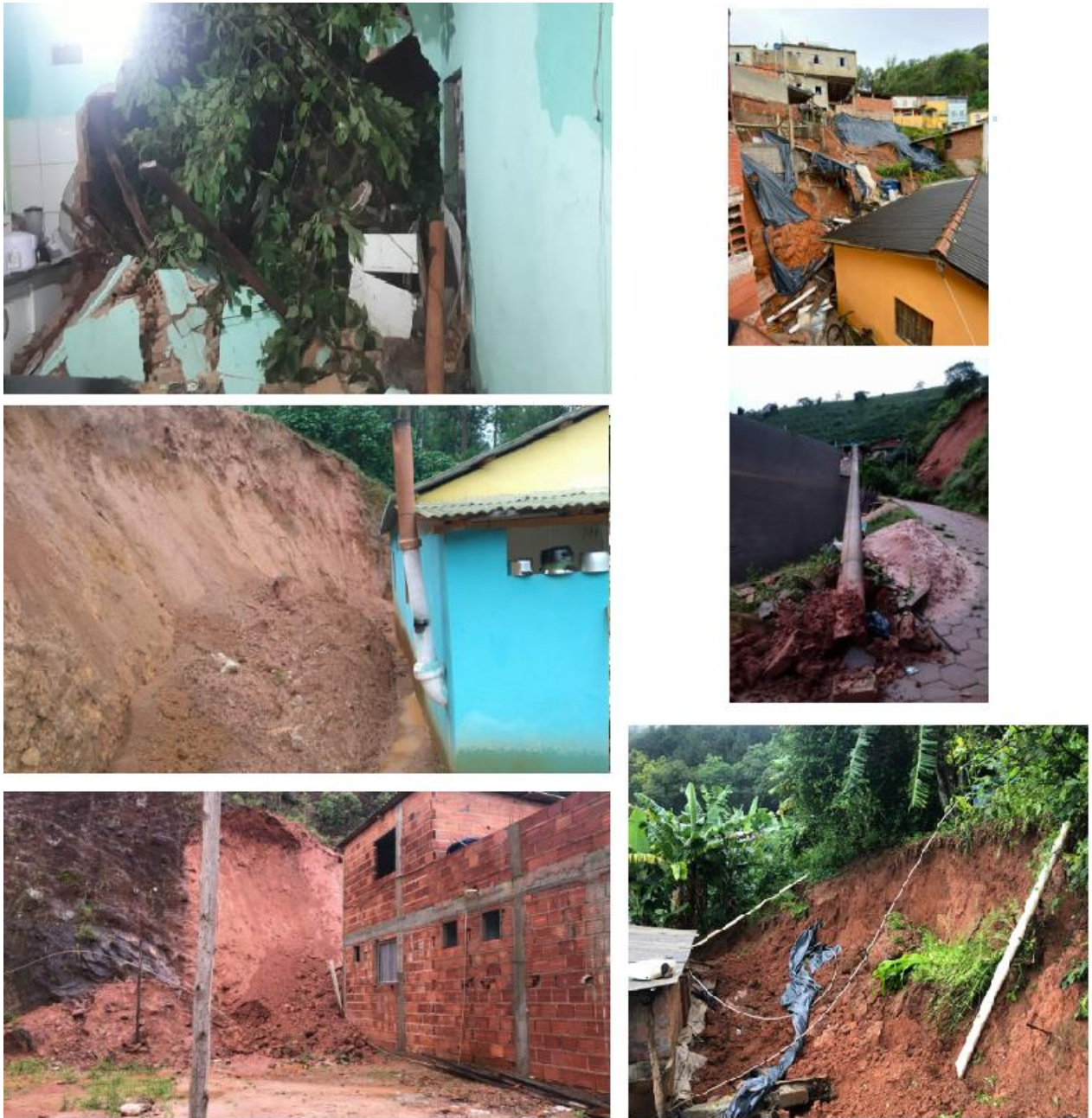
Figura 13: Mosaico -Registros de Deslizamentos em Ibatiba -2022/2023.
