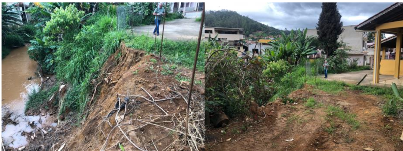
Figura 18: Coordenador Municipal em vistoria- área de risco de inundação.
