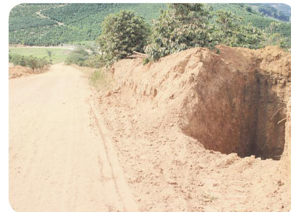
CONSTRUÇÃO DE CAIXAS-SECAS PARA EVITAR DANOS CAUSADOS PELA ÁGUA DA CHUVA.
