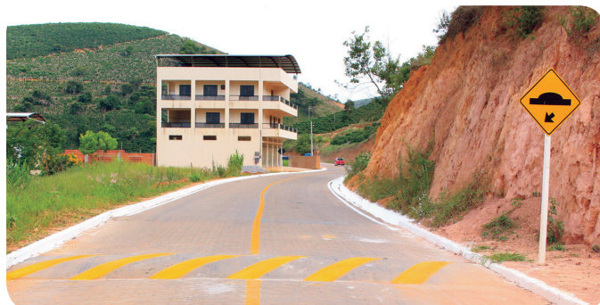
PROGRAMA CAMINHOS DO CAMPO: INAUGURADA OBRA DE PAVIMENTAÇÃO DO TRECHO DE APROXIMADAMENTE 5 QUILOMETROS, QUE DÁ ACESSO ÀS COMUNIDADES DE CAMBRAIA, CÓRREGO IPÊ E SANTA MARIA.
