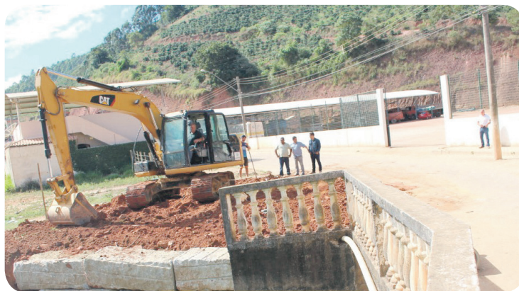
OBRAS NA PONTE DO BAIRRO SÃO SEBASTIÃO.
